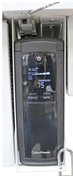
Die unterbrechungsfreie Stromversorgung (USV) ist vor dem Hauptschalter angeschlossen. Wenn die normale Stromversorgung unterbrochen wird, schaltet die Maschine automatisch auf Akkubetrieb um. So können der aktuelle Nähvorgang fertiggestellt und die Maschine ordnungsgemäß ausgeschaltet werden, ohne dass es zu Datenverlusten kommt.
